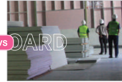
Drywall - Proyek bersih & rapih
